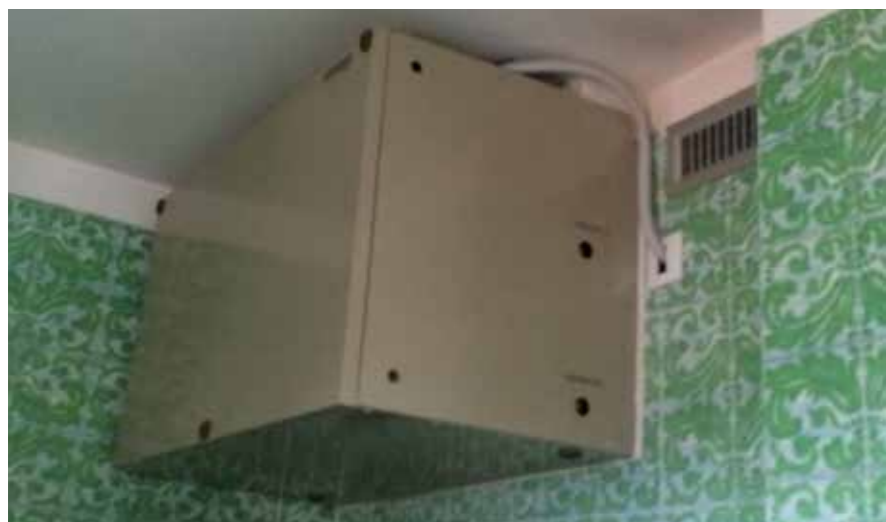
SITUAZIONE FINALE - SOSTITUZIONE MACCHINA
